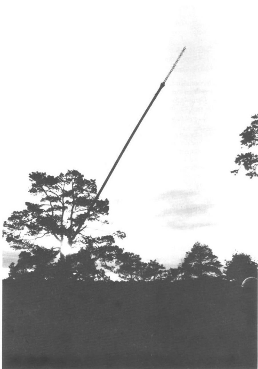
Radiomast på väg ner.
